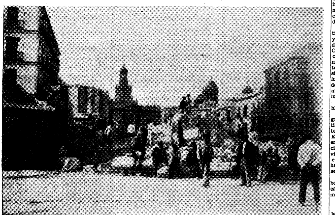
Otro aspecto de los derribos a la entrada de la ciudad
