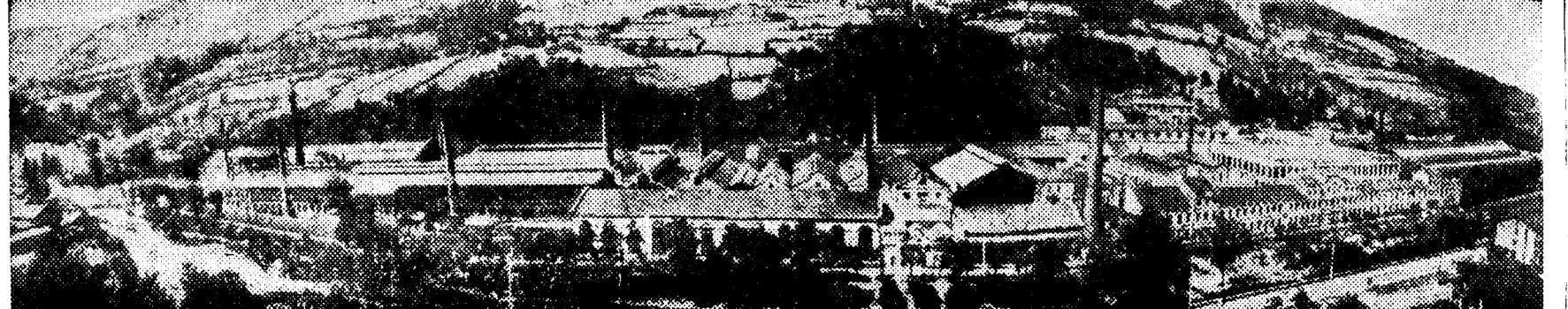
Vista general de la Fábrica Nacional de Toledo
