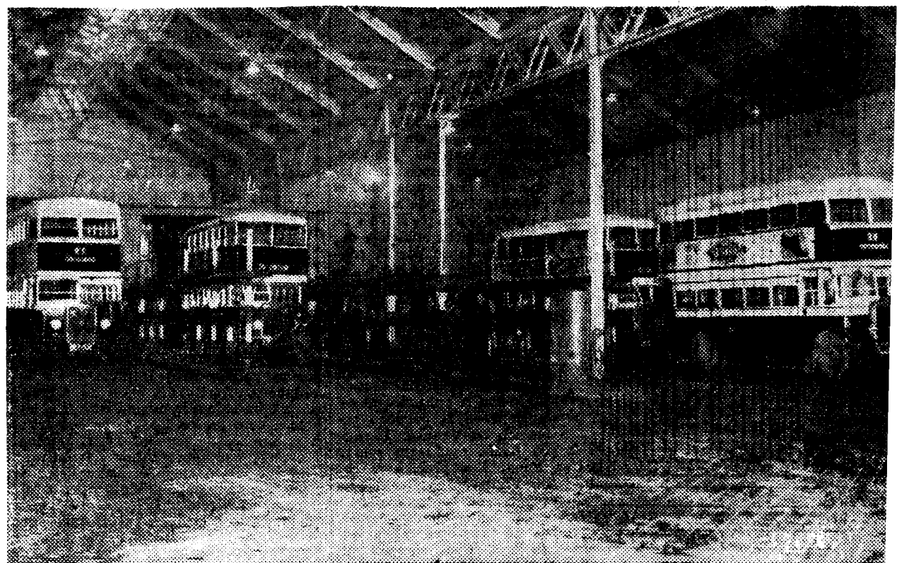
Vista de una parte del magnífico garage de Pozas
