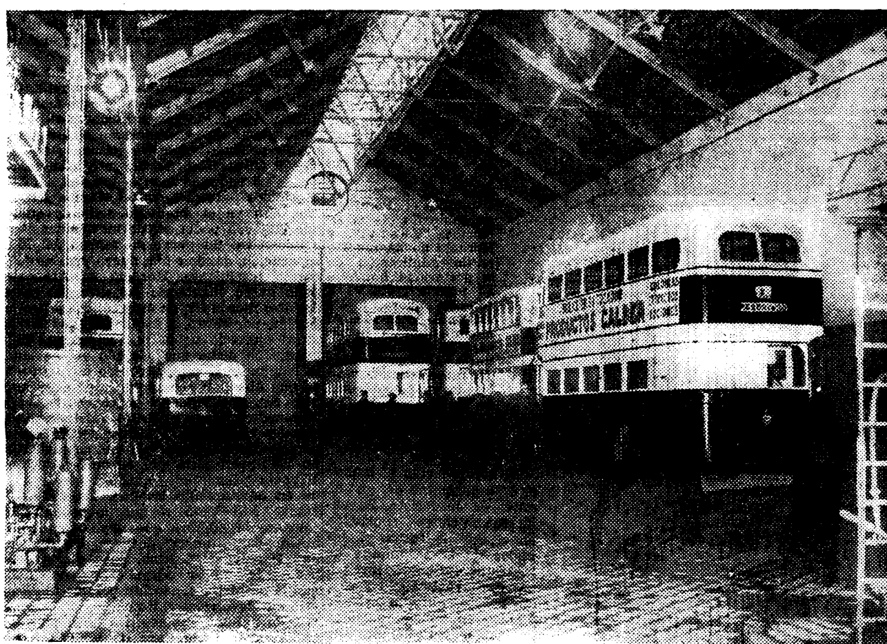
Vista de una parte del magnífico garage de Pozas
