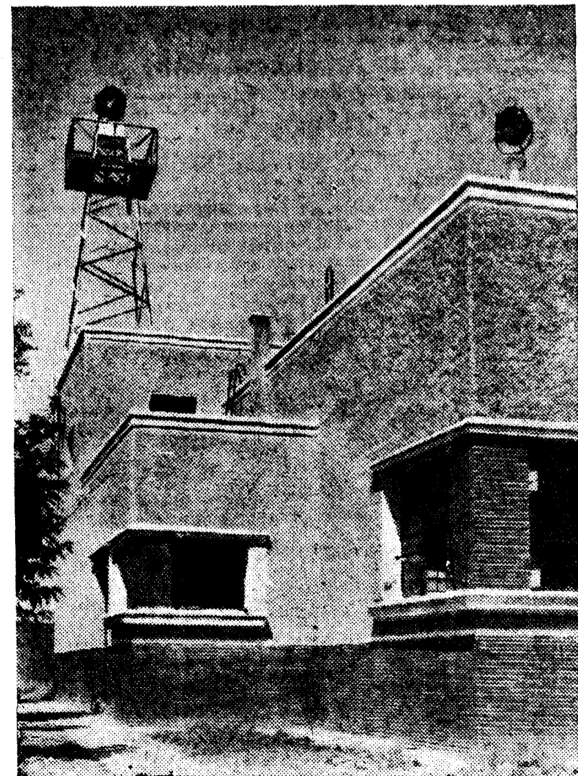
Vista diurna del faro de posición, instalado en el aeropuerto, sobre la celosía de 15 metros
