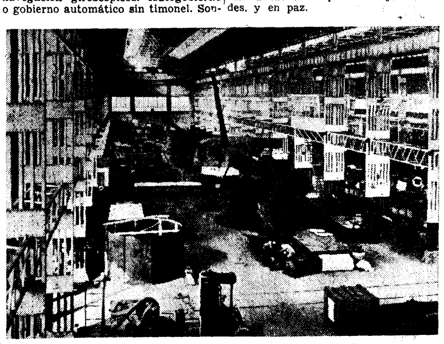
Taller de construcción de artillería (Torres). Cádiz
