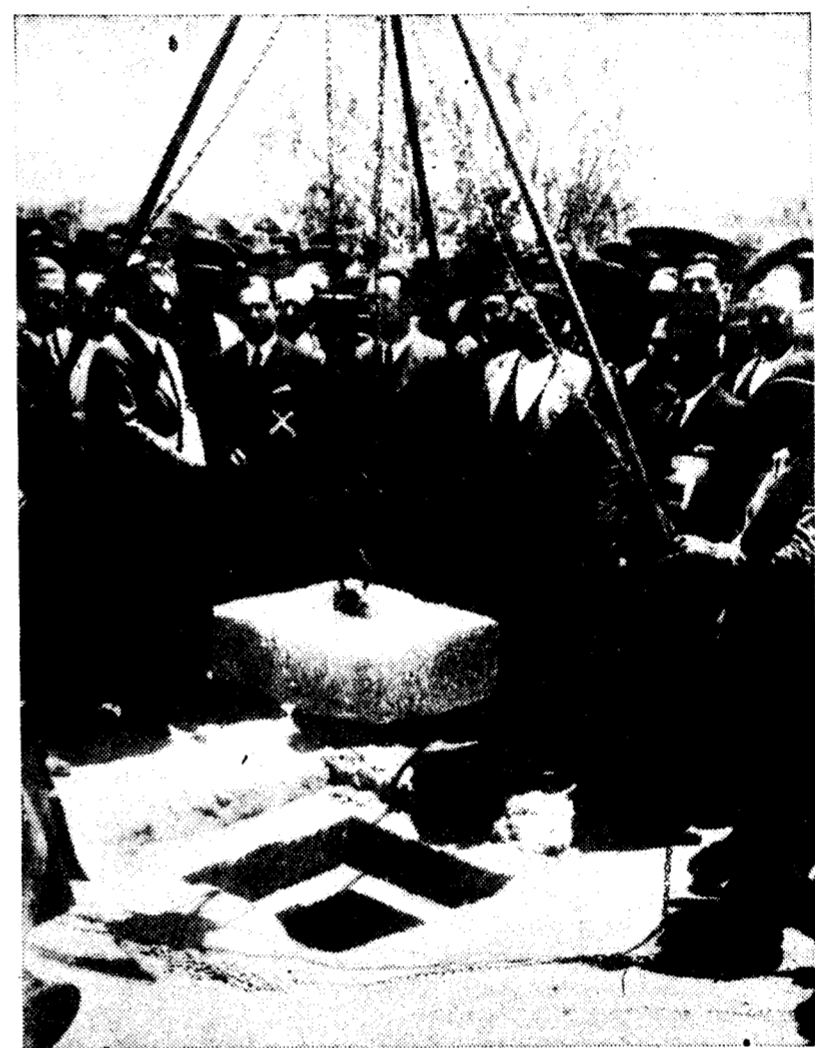
Muchísimos pueblos españoles aguardan la colocación de una primera piedra; ¡Obras! Obras útiles, benéficas, sanitarias. Obras
