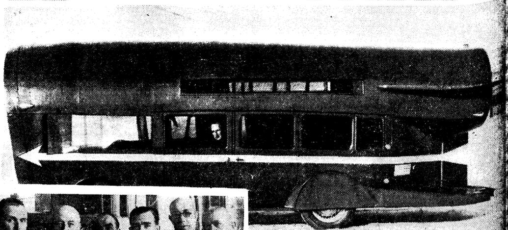
Un vehículo movido por hélice ideado por Mr. Thomas M. Finley. Pesa 5.000 libras, y el cuerpo va montado en un «chassis» de camión. Alcanza una velocidad de 47 millas por hora (Foto Vidal)
