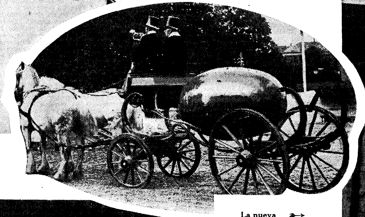
La nueva hélice construída para el «Normandie» mide cinco metros y medio de diámetro, y pesa 28 toneladas (Foto Vidal)
