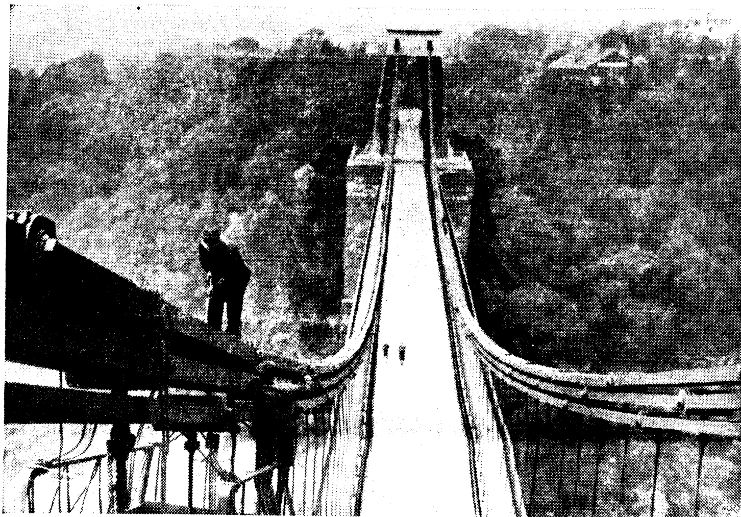
Sobre un abismo de 250 pies, el monumental puente colgante de Clifton, en Bristol, semeja, en la curiosa perspectiva de la foto, lanzar el dardo del camino a través de la masa umbría de la ribera del río Avon. En la peligrosa altura de las cadenas de suspensión del puente, unos trabajadores se dedican a la tarea, repetida cada cuatro años, de repararlas y pintarlas
